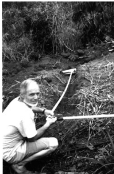
David Hosick instaleaza țevile pentru apă curentă la fiecare clădire din campus
